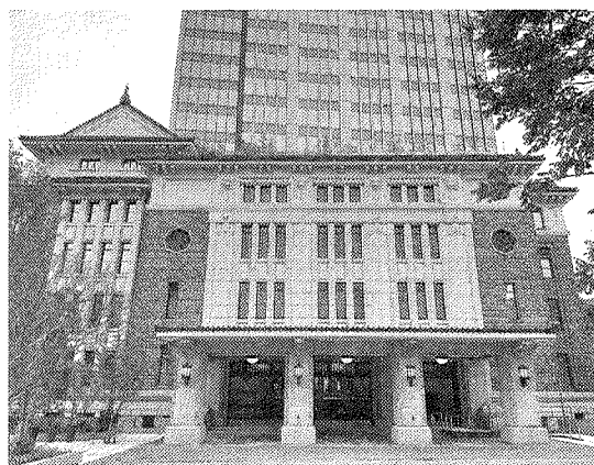
登録有形文化財の旧九段会館(保存部分)と現代建築が融合する「九段会館テラス」
