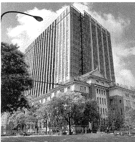
7月29日に竣工した「九段会館テラス」=8月8日撮影
