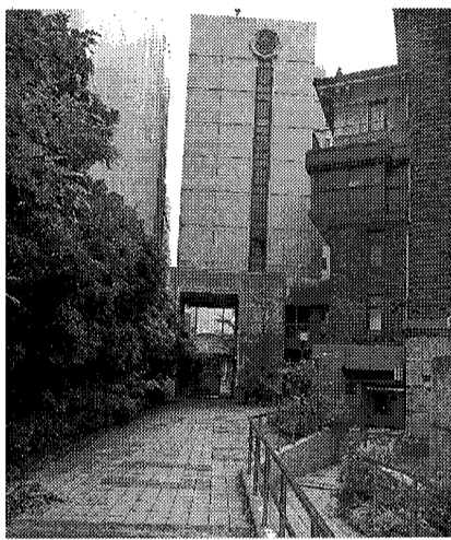
解体工事前の新館ホテル
